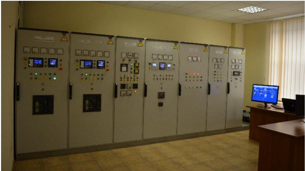
Рис.2.14, а. Секції ГРЩ: основних дизель-генераторів, синхронізації та управління, валогенератора, живлення з берега і аварійного дизель-генератора
