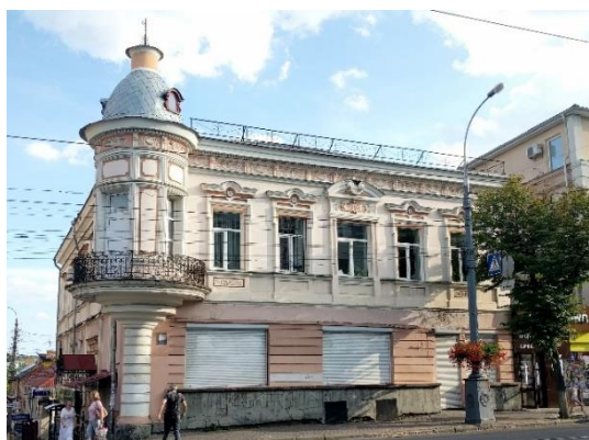
Рис. 3.26 Прибутковий будинок, вул. Соборна, 37(1890 р., арх. В. Краузе (?). Фото автора, 2018 р.
