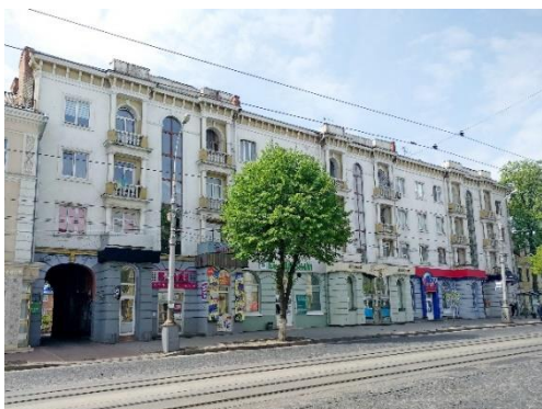
Рис. 4.23 Житловий будинок Облвиконкому, вул. Соборна, 81 (1936 р.). Фото автора, 2018
