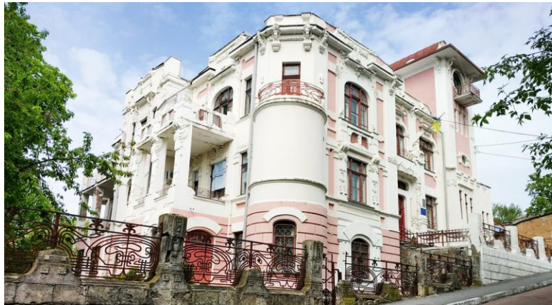
Будівля Департаменту архітектури та містобудування (особняк Четкова), вул. Пушкіна, 38. Фото автора, 2018 р. Пам'ятка місцевого значення, охоронний номер 24-М
