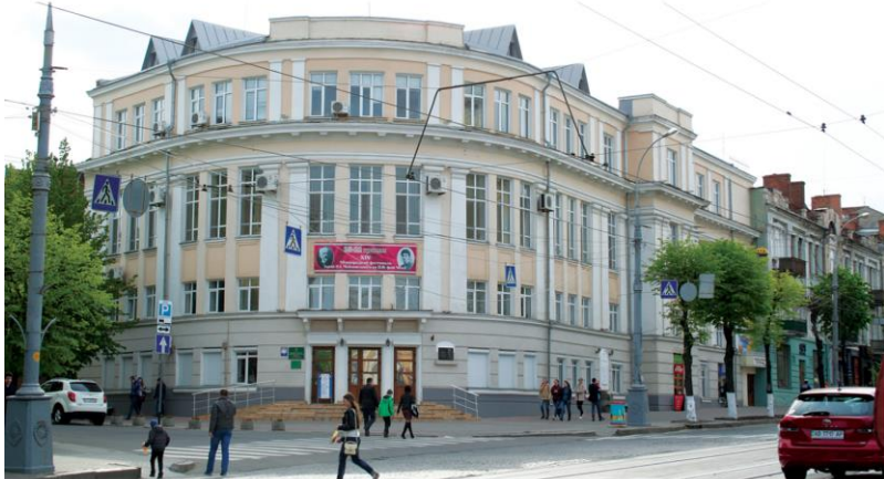
Будівля ВОУНБ ім. К. А.Тімірязєва (гоголівська читальня), вул. Соборна, 73. Фото автора, 2018 р. Пам'ятка місцевого значення, охоронний номер 373-Вн
