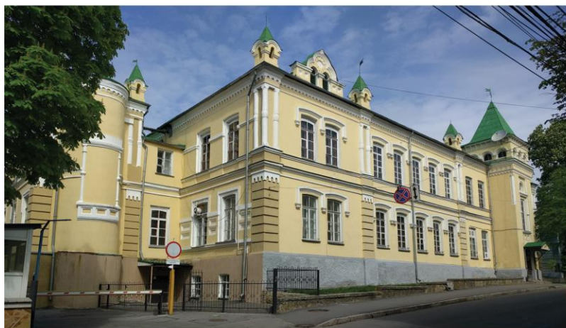
Фасад по вул. Театральній. Фото автора 2018 р.
