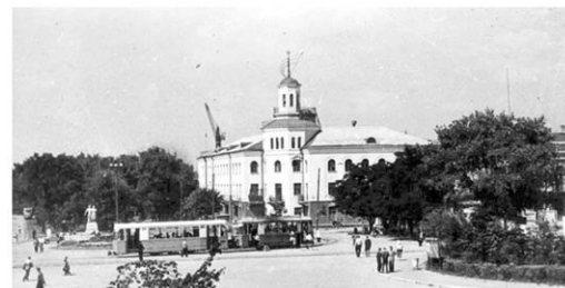
Адмінбудинок агрегатного заводу. Фото 1950-х рр. (архів арх. Л. Денисової)
