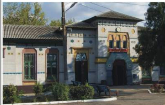
Будинок міського училища ім. С. Г. Грушевського, архіт. В. Г. Кричевський, Е. П. Брадтман. Фрагмент стіни. Сучасний вигляд 1.
