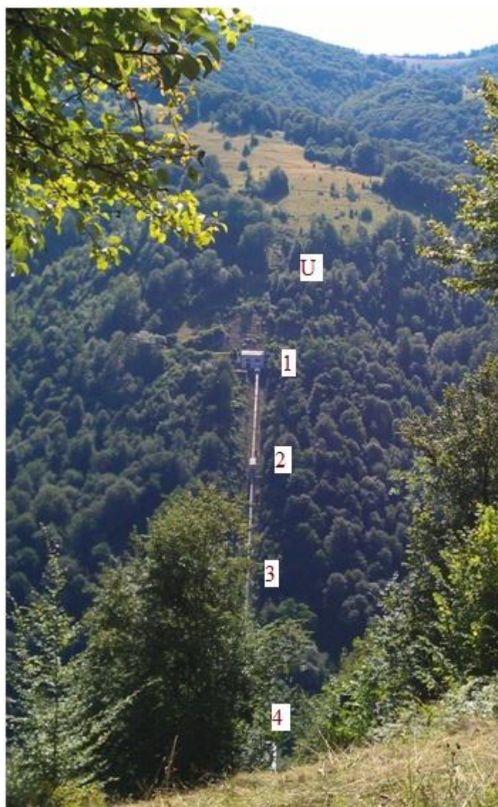
Рис. 3.11 Спостереження з пункту Р на пункти U, 1, 2, 3, 4 інженерно-геодезичної мережі Теремле-Ріцької ГЕС
