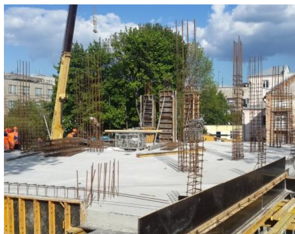
Рисунок 6.3 – Бетонування монолітного перекриття (а) та колон (б)
