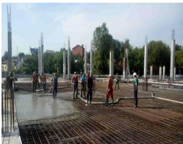
Рисунок 6.3 – Бетонування монолітного перекриття (а) та колон (б)
