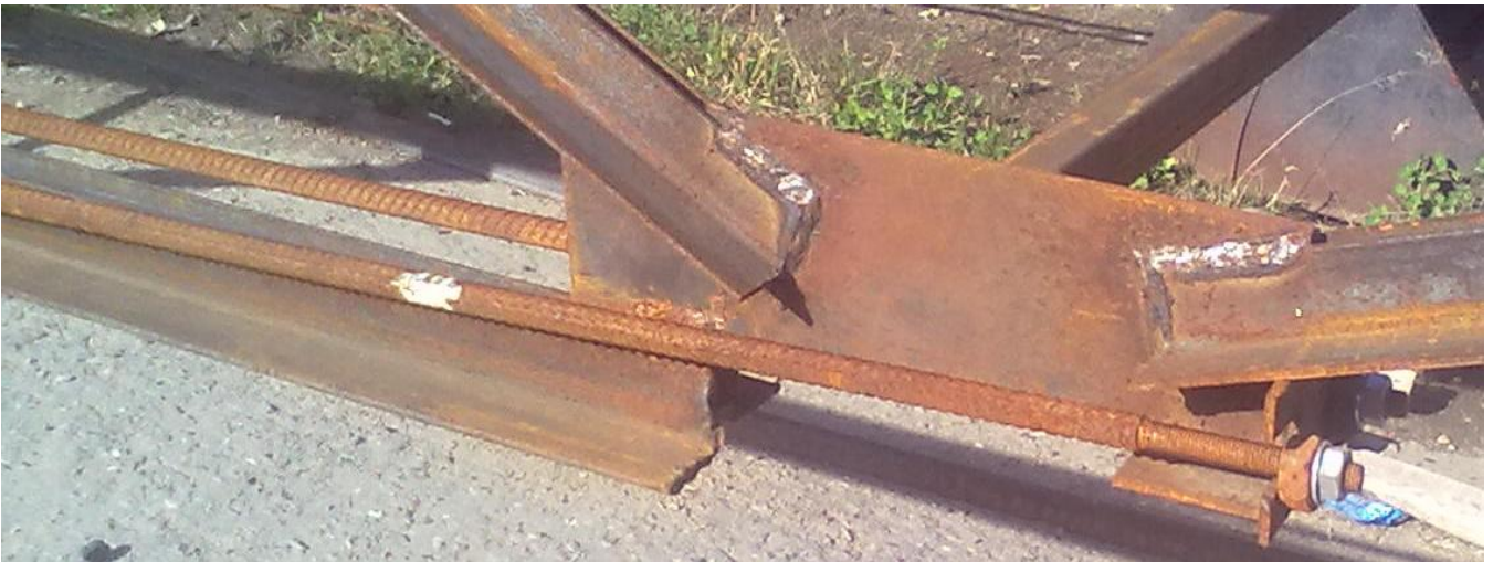
Рис.2.8. Вузол шпренгеля натурної моделі комбінованої попередньо напруженої МШК на стадії виготовлення
