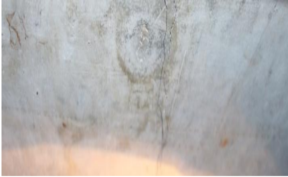
Рис. 4.34. Тріщини в залізобетонній плиті комбінованої сталевозалізобетонної попередньо напруженої шпренгельної конструкції: а) - в нижній поверхні; б) - на торцевій грані
