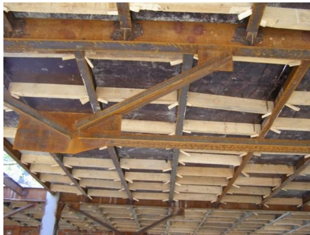
Рис. 4.47. Використання комбінованих сталезалізобетонних попередньо напружених шпренгельних конструкцій при влаштуванні перекриттів будівлі відпочинкового комплексу санаторію «Женева» ( м. Трускавець, вул. Суховоля, 63): а) - влаштування попередньо напружених комбінованих металевих шпренгельних конструкцій (I-ий етап); б) - влаштування залізобетонної плити по попередньо напружених комбінованих металевих шпренгельних конструкцій (II-ий етап); в)- просторова перехресно ребриста комбінована сталезалізобетонна попередньо напружена шпренгельна конструкція.
