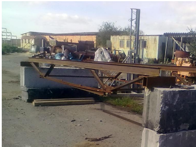
Рис. 4.3. Статично невизначені комбіновані металеві шпренгельні конструкції на початковій стадії виготовлення
