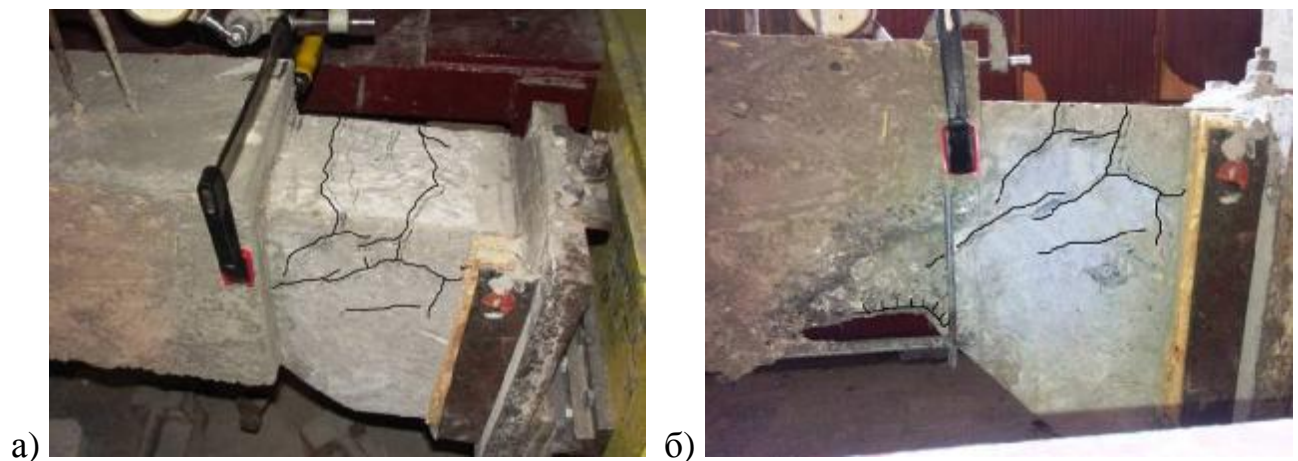
Рис. 2.18. Руйнування консольної частині колони КП-03-0,0: а) розколювання бетону; б) руйнування стиснутої зони основного перерізу.
