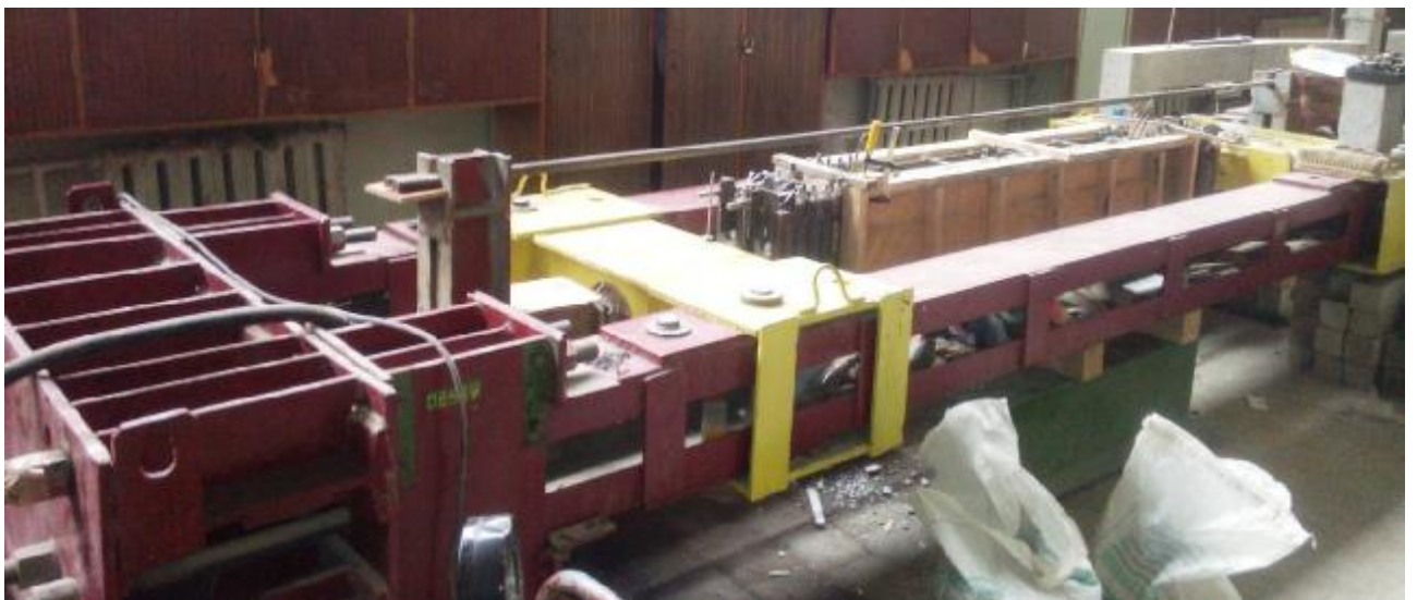
Рис. 2.22. Колонa у процесі підсилення.
