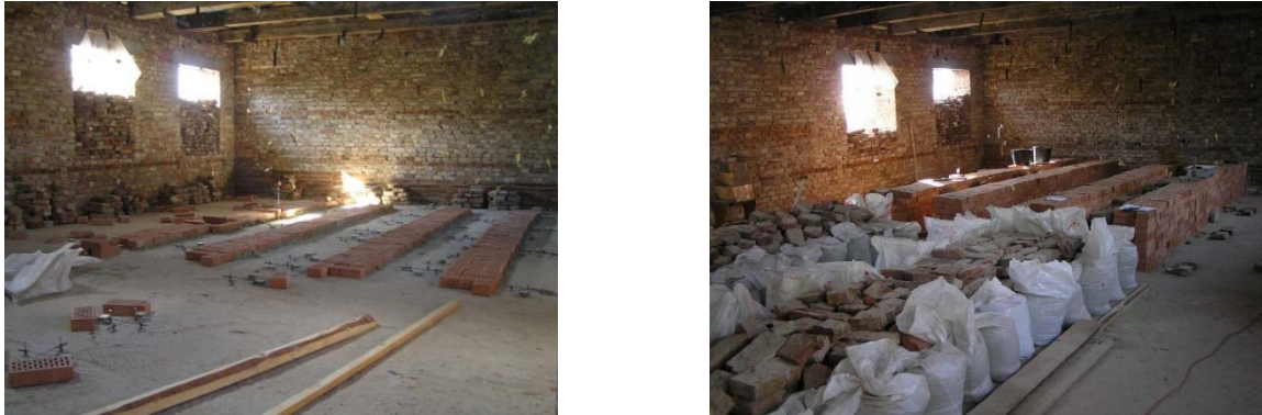
Рис. 6. Загальні вигляди випробування натурального перекриття.
