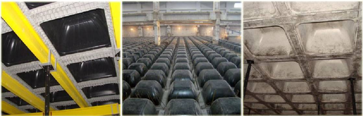
Рис. 1.22. Загальний вигляд монолітного кесонного перекриття в процесі виготовлення.
