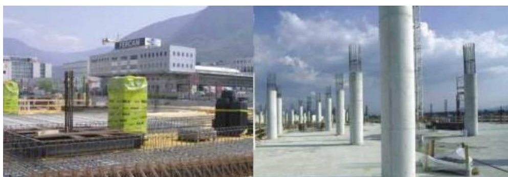
Рис. 1.33. Загальний вигляд на улаштування перекриття з вставками сферичної форми систем IGLU.
