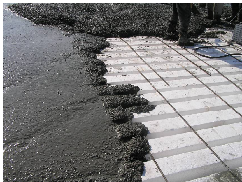
Рис. 2.21. Загальні вигляди улаштування перекриття.
