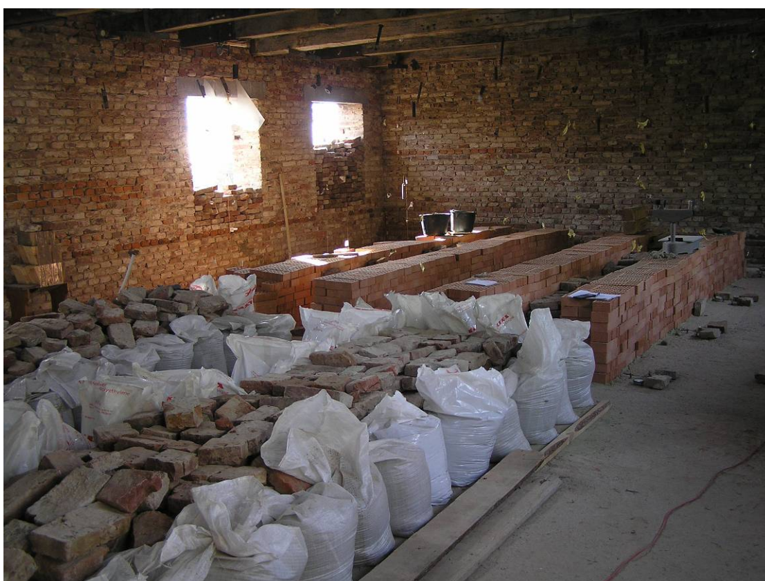
Рис. 2.25. Загальні вигляди випробування перекриття.
