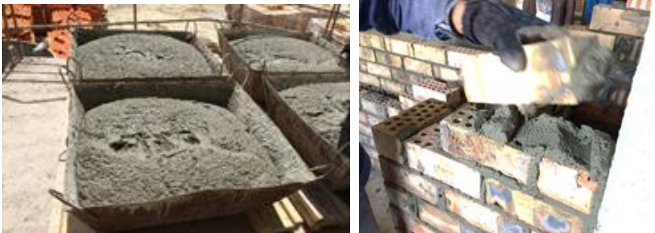
Рисунок 5.5 – Приготування мурувального розчину на основі ЦБР 300 на будівельному майданчику (вул. Кругла)
