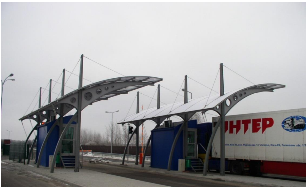
Рис.3.4.8. Вантові конструкції навісів у МАПП « Дорогуськ»
