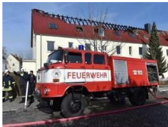
Рис. 3.17. Постраждалий від пожежі притулок для мігрантів м.Тройгліц [61]
