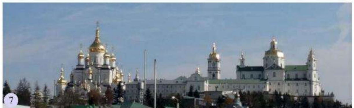
Сучасні споруди Почаївської Лаври: 1 - Літній храм; 2- Економічні ворота; 3 - готель і підземний перехід; 4 - Собор Преображення Господнього (2010-2013 рр., арх. Новгородов В.); 5 - центральний купол собору; 6 - іконостас в процесі роботи; 7 - панорамний вид(власні фото).
