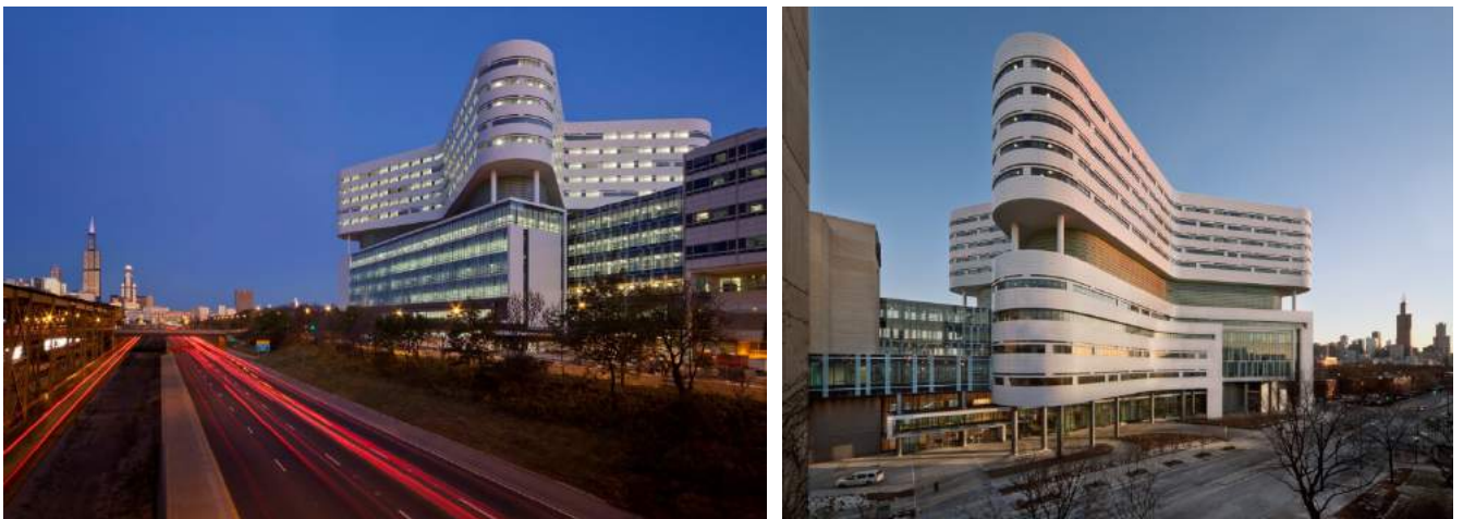
Рис. 2.1.2 Будівля Ортопедичної амбулаторії для медичного центру університету Раш (Чікаго, Іллінойс, США). Архітектори «Perkins & Will». Розроблено автором з використанням (Perkins and Will. This Is What Rush Was Built For [online])
