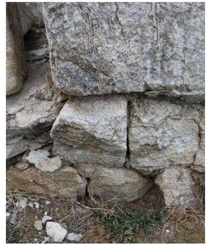
Рис.4.1.1.24. Стіни каплиці св. Василя Великого, с. Крилос, Івано-Франківська область. Процес вивітрювання, розшарування, розтріскування. Вимивання кристалічної маси з утворенням борозен
