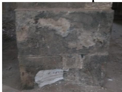
Рис.4.1.1.2. База арки в костелі св. Івана Євангеліста і 40 мучеників у с. Кукільники. Фізико-хімічні пошкодження: соляні відклади, зміна забарвлення, вивітрювання
