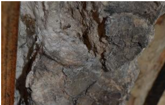
Рис.4.1.1.30. Віконні обрамлення каплиці Снопковських («Аріанська Вежа»), м. Белз, Львівська область. Процес вивітрювання кристалічної маси, розчинення та розшарування. Атмосферні забруднення
