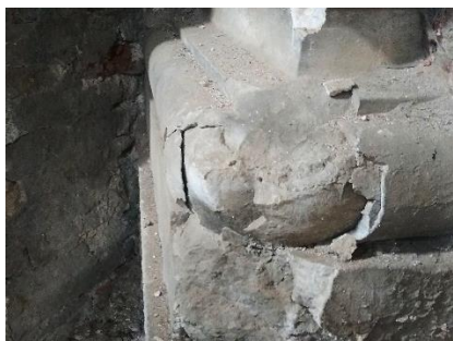
Рис. 4.1.1.1. База колони в костелі св. Івана Євангеліста і 40 мучеників у с. Кукільники. Механічні пошкодження: сколи та тріщини
