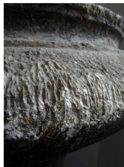
Рис. 4.1.2.28. Результат дії стічної води. Розчинення кристалічної маси алебастру за напрямом стоку води
