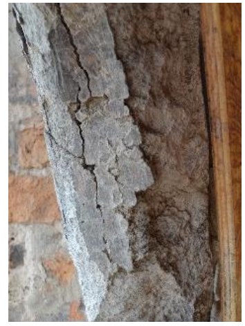
Рис.4.1.1.30. Віконні обрамлення каплиці Снопковських («Аріанська вежа»), м. Белз, Львівська область. Розшарування та розтріскування кристалічної маси. Атмосферні забруднення.
