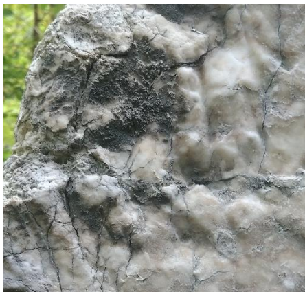
Рис.4.1.1.30. Віконні обрамлення каплиці Снопковських («Аріанська Вежа»), м. Белз, Львівська область. Процес вивітрювання кристалічної маси, розчинення та розшарування. Атмосферні забруднення
