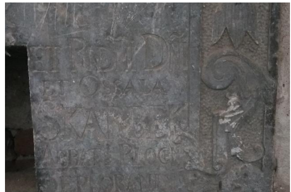
Рис.4.1.1.9. Саркофаг М. Вижицького у Подряпини, атмосферні забруднення. Зміна забарвлення. Механічні сколи. Вивітрювання
