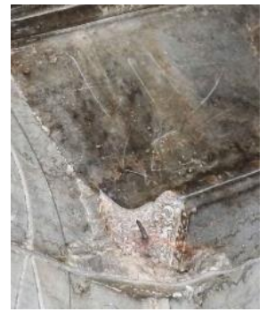
Рис.4.1.1.9. Саркофаг М. Вижицького у Подряпини, атмосферні забруднення. Зміна забарвлення. Механічні сколи. Вивітрювання
