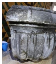
Рис. 3. Очищення від вапняних набілів латексною плівкою з ПВА та крохмалю
