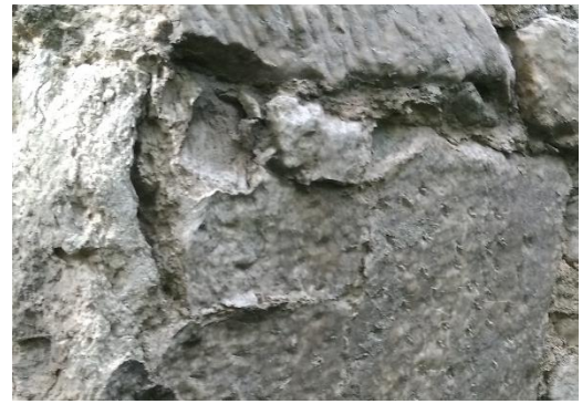
Рис.4.1.1.31. Контрфорси костелу св. Івана Євангеліста, Марії Магдалини і 40 мучеників (XVIII ст.) у с. Кукільниках, Івано-Франківська область. Вимивання глинистої складової, процес розчинення та вивітрювання кристалічної маси
