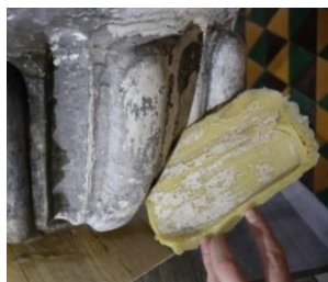
Рис. 2. Очищення латексною плівкою Arte Mundit Reiniger-Piling Typ II, III, V Komponente A, фірми Remers
