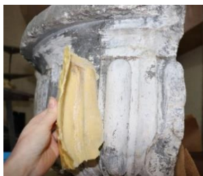
Рис. 1. Очищення від вапняних набілів, матеріал Arte Mundit Reiniger-Piling 222030 фірми Remers
