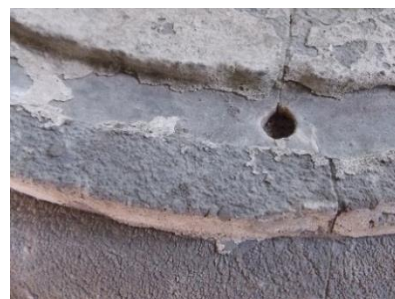
Рис. 4.1.2.33. Борозни за напрямом стоку води, результат розчинення кристалічної маси
