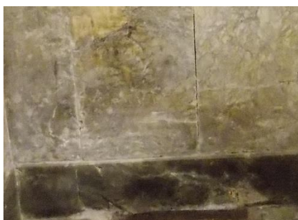
Рис. 4.1.1.12. Поручні в холі Науково-технічної бібліотеки НУ «ЛП». Механічні пошкодження: подряпини, потертості, тріщини
