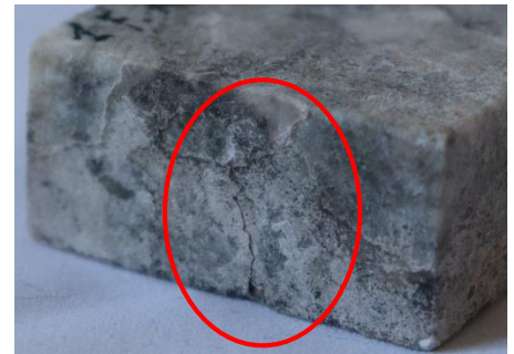
Рис. 4.5.3.3. Тріщина посередині торця каменю, покритого Funcosil AS
