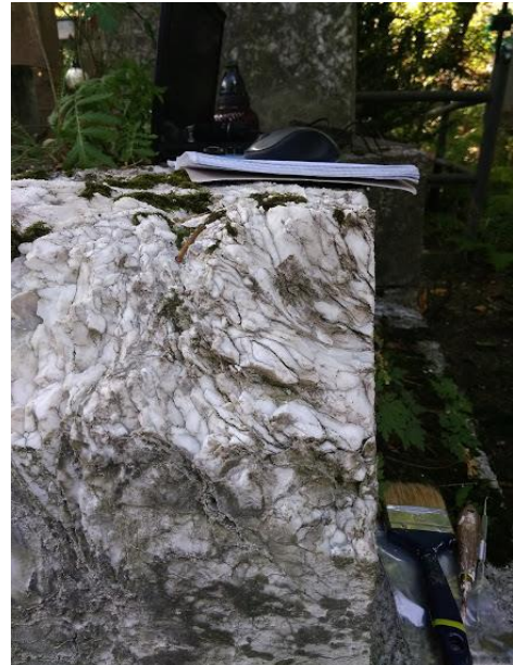
Рис. 4.1.2.23. Глибоке розтріскування каменю
