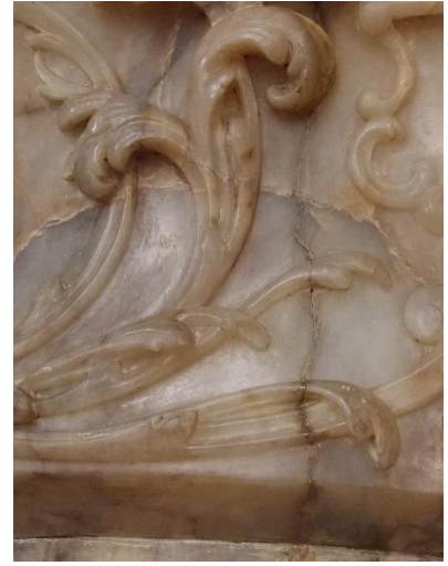
Рис.4.1.1.19. Фрагмент каміну в одній з кімнат Будинку вчени, м. Львів. Глибокі тріщини
