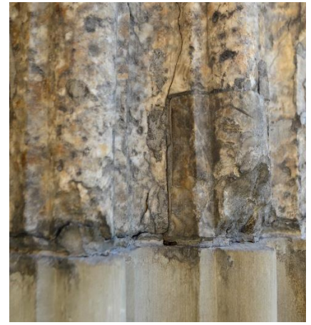
Рис.4.1.1.27. Алебастровий портал костелу Успіння Пресвятої Діви Марії, Св. Христа і св. Варфоломія в м. Дрогобичі. Блок 13. Вторинні вставки, фугування цементними розчинами. Механічні пошкодження
