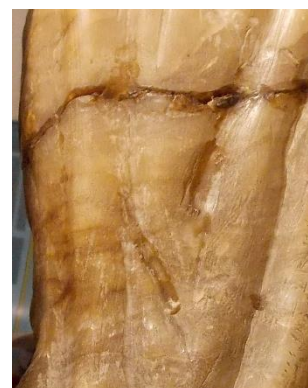
Рис.4.1.1.14. Вестибюль Будинку архітектора, Порохова вежа, м. Львів. Тріщини зафуговані гіпсовим розчином. Подряпини
