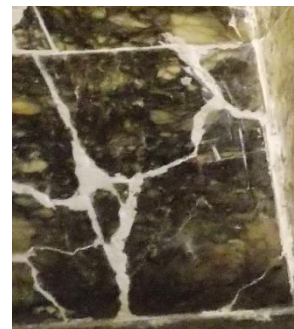
Рис.4.1.1.14. Вестибюль Будинку архітектора, Порохова вежа, м. Львів. Тріщини зафуговані гіпсовим розчином. Подряпини
