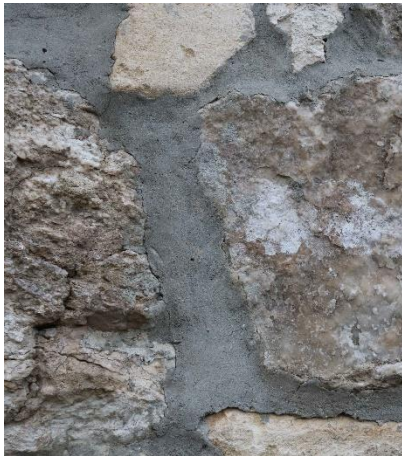
Рис.4.1.1.25. Стіни каплиці св. Василя Великого, с. Крилос, Івано-Франківська область. Фугування швів між блоками цементним розчином
