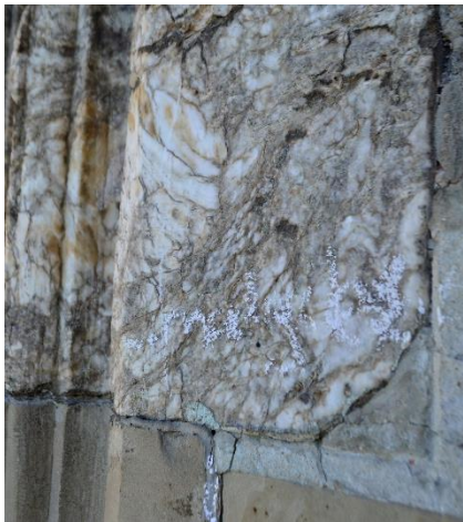
Рис.4.1.1.28. Алебастровий портал костелу Успіня Пресвятої Діви Марії, св. Христа і св. Варфоломія в м. Дрогобич. Блок 13. Процес розшарування, розтріскування кристалічної маси. Атмосферні забруднення
