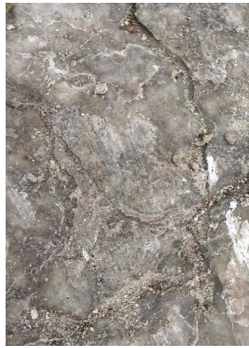
Рис.4.1.1.23. Фрагмент дороги до монастиря походження дерева Хреста Господнього, с. Підкамінь, Бродівський район, Львівська область. Процеси розшарування, розчинення. Утворення дрібних тріщин
