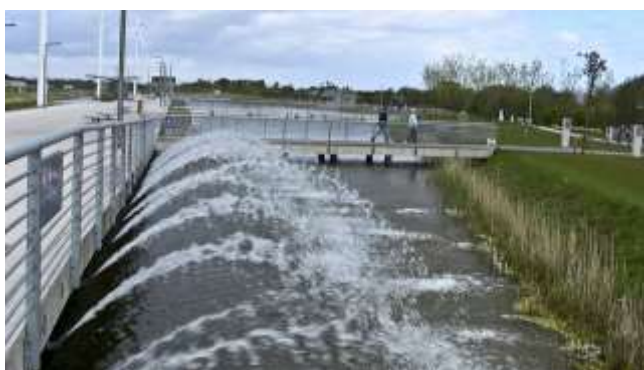
Рис. 1.3. Басейн для аерації води (автор світлині William Murphy; її взято з сайту: http://biofile.ru/geo/4804.html )
