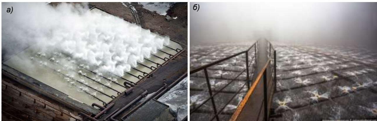
Рис. 1.6. Споруди для охолодження циркуляційної води у ТЕС і АЕС: а – бризкальний басейн; б – РТ з соплами-розпилювачами в градирні Карагандинської ТЕЦ-3 (світлина Вадима Махорова взято з сайту: http://loveopium.ru/tehnologiya/gradirni.html )
