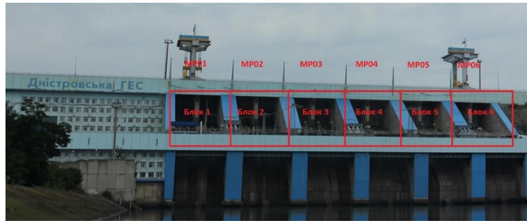
Рисунок 3.8 – Розміщення ГНСС-пунктів МР1-МР6 відносно блоків греблі Дністровської ГЕС-1
