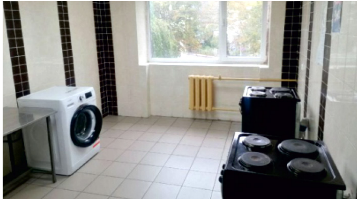
Ремонт приміщень загального користування в гуртожитку № 4
