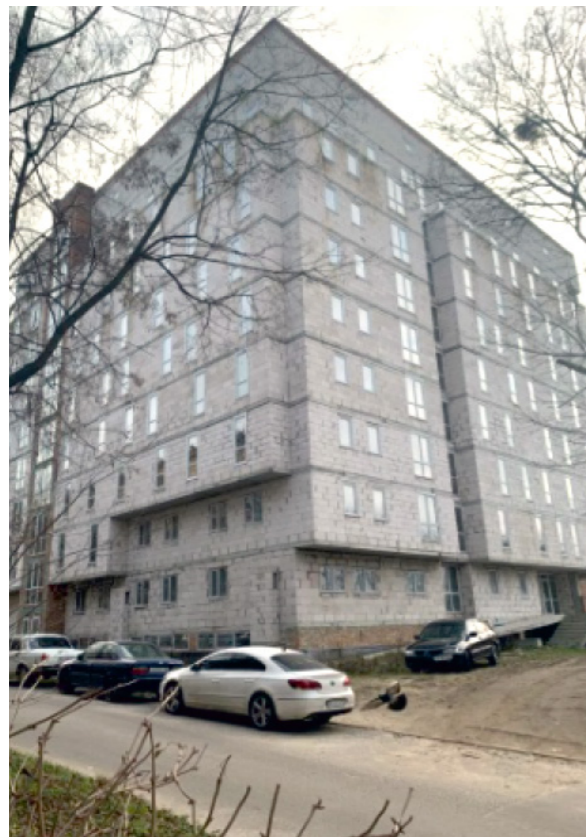
Будівництво гуртожитку (вул. Відкрита)
