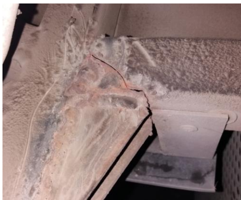
Рисунок 2.11 – Тріщина труби каркасу основи кузова в передній частині
