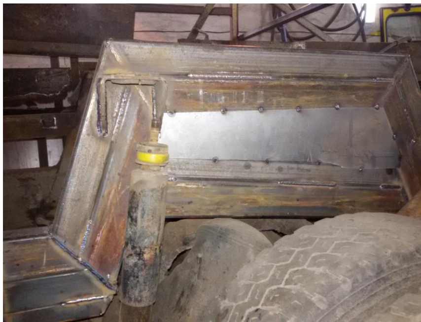
Рисунок 4.31 – Відновлення каркасу основи кузова автобуса
