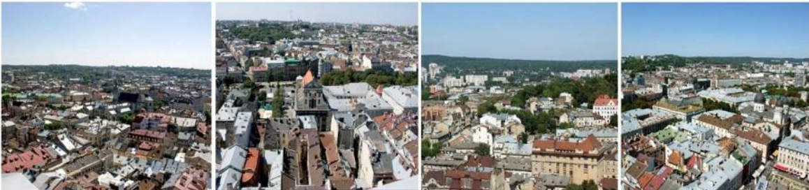
Вигляд на захід
