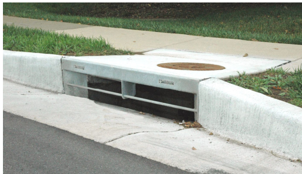
Рис. 1.6. Високоміцний сталевий бордюрний дощоприймач типу А конструкції компанії Shawnee Steel & Welding (США)
