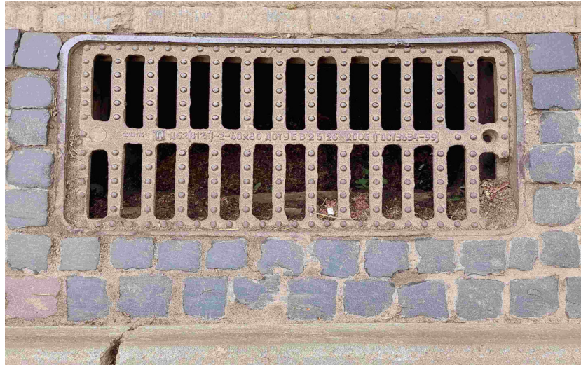
Рис. 1.4. Дощоприймальна решітка типу ДБ2(В125) з габаритними розмірами 800×400 мм, периметром вхідного отвору 778×378 мм та поперечними отворами (шпаруватість \epsilon=0,310 )
