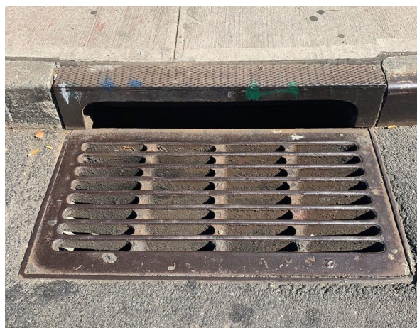
Рис. 1.7. Комбінований посилений чавунний дощоприймач EPA 6" (American Cast Iron Products, Inc.)
