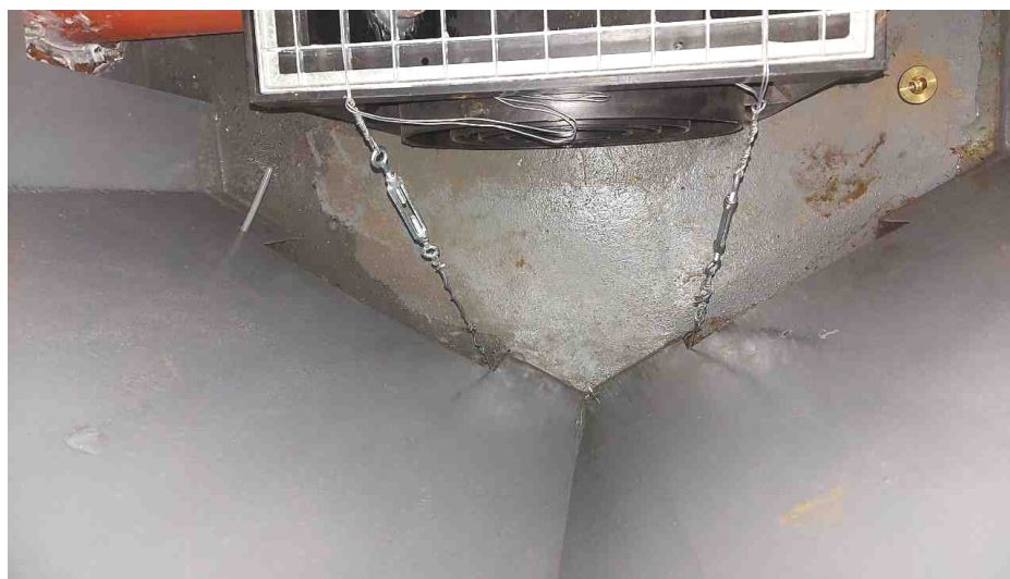
Рис. 2.7. Спеціальні кріплення дощоприймачів і трапів
