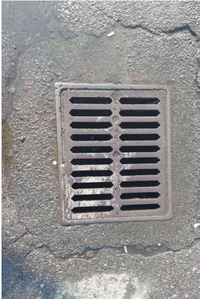
Рис. 5.6. Дощоприймальна решітка типу ДБ2(В125) з габаритними розмірами 540×440 мм, периметром вхідного отвору 490×390 мм та поперечними отворами у м. Львові, по вул. Володимира Великого, 24:
