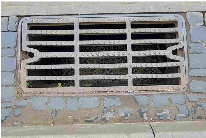
Рис. 1.3. Дощоприймальна решітка типу ДБ2(В125) з габаритними розмірами 850×400 мм, периметром вхідного отвору 810×380 мм та поздовжніми отворами (шпаруватість \varepsilon=0,310 )
