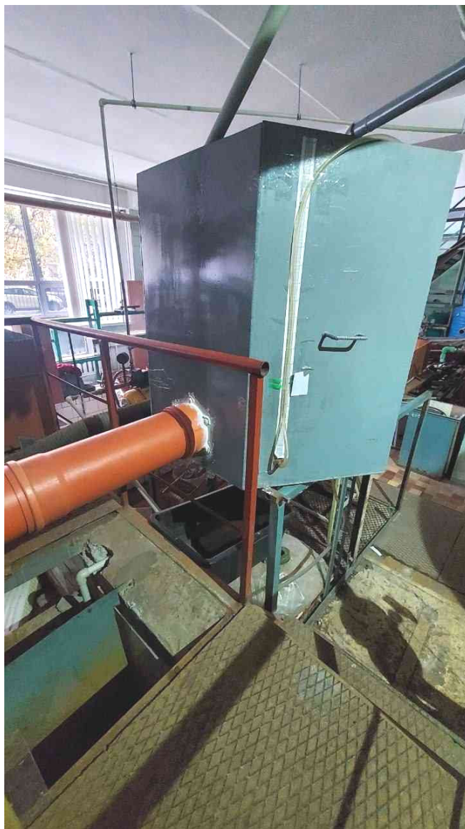
Рис. 2.5. Дослідний резервуар зі змонтованим відвідним трубопроводом діаметром 200 мм
