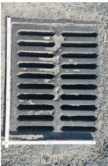
Рис. 5.7. Дощоприймальна решітка типу ДБ2(В125) з габаритними розмірами 540×440 мм, периметром вхідного отвору 490×390 мм та поперечними отворами у м. Львові, по вул. Володимира Великого, 51:
