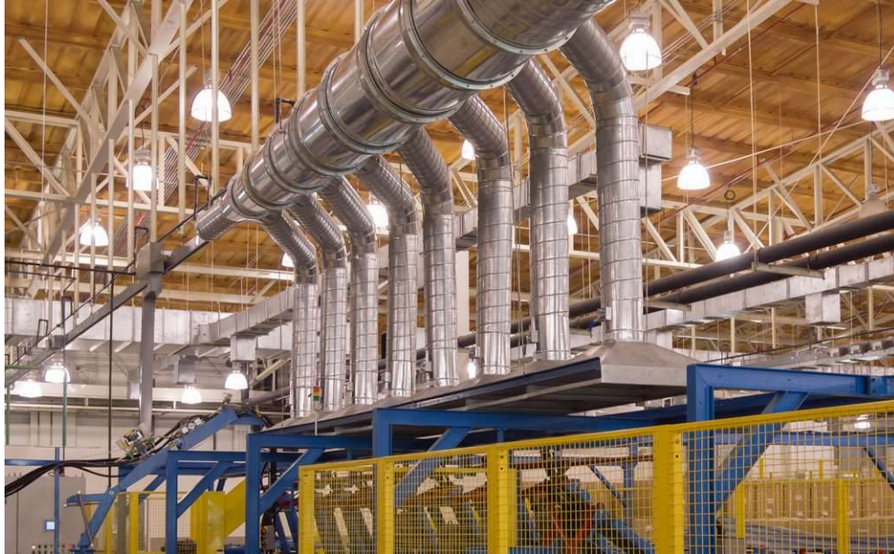
Рис. 1.13. Трубопровід-збирач у витяжній вентиляції промислового підприємства
